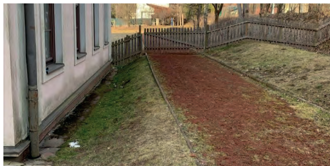
Die Laufbahn der VS und MMS Seeboden wird erneuert
